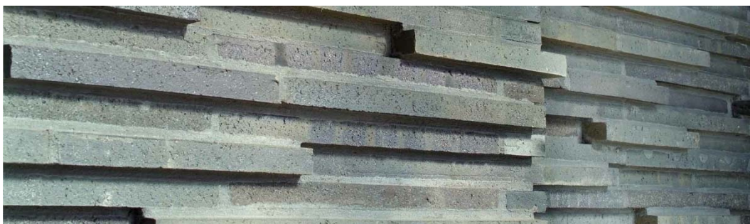
Eksempel på reliefvirkning i facaden. Foto: Kalk og Teglværksforeningen.
